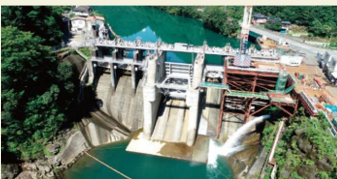
「西郷ダム」に続き2番目に出来たダム。現在改修工事中で2022年に完成予定。新設された大型ゲートは国内のラジアルゲートの中で面積が最大。大型ゲートを支える門柱には凹凸があり西洋の城門を連想させるようないまい。
