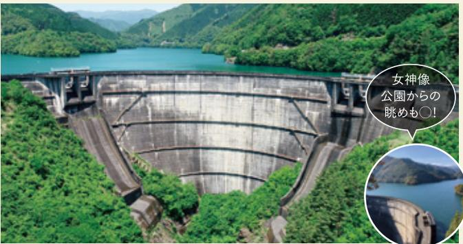
1955年完成、100m超の大規模アーチダムにおいて日本初!流下する水のエネルギーを弱める減勢工(げんせいこう)では「スキージャンプ式」を採用。両岸から放流する2つの水をぶつかり合わせ勢いを弱めている。
