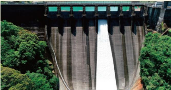
「上椎葉ダム」と「塚原ダム」の中間に位置し、豊かな緑を映す閑静なダム。塚原ダム建設で培った日本初近代化施工技術をさらに改善し建造。斜めに整列した9つのピアやダム上流面の張り出し部の曲線もキレイ。
