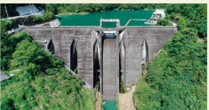
建造コストを抑えるため、中が空洞になっている重力式ダム。空洞部分があるためダムの敷地面積が広くなり安定する、という利点もあり。ダムの下流側には、5つのスリット(切れ目)が入っている。九州で中空重力式ダムが見られるのはココだけ。
